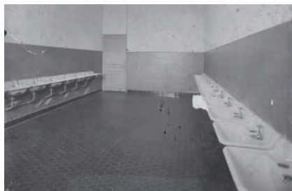
1932. Sanitaires de l'internat.
